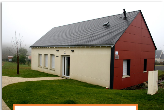
Façade Avant - Entrée principale
