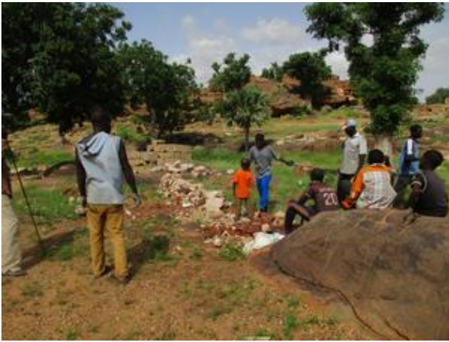
19 - Implantation des latrines - Le 20.09.2016
