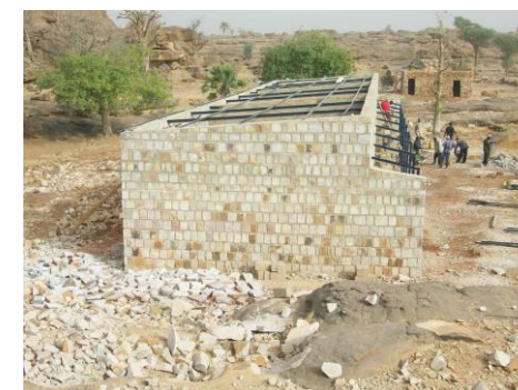
Photo des travaux au 27.01.2016
